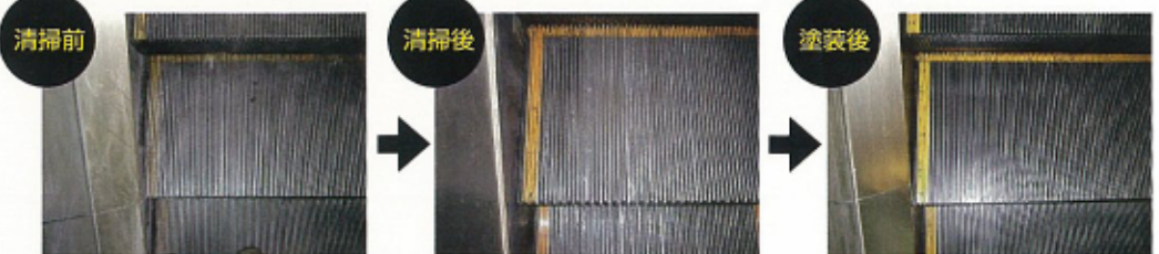
ステップを設置したままで、補修塗装が可能（工法特許第2906143号）
